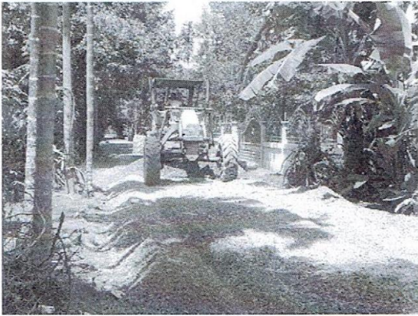
๘. โครงการก่อสร้างถนนลาดยาง ซอยสุวรรณ ๒ หมู่ที่ ๗
