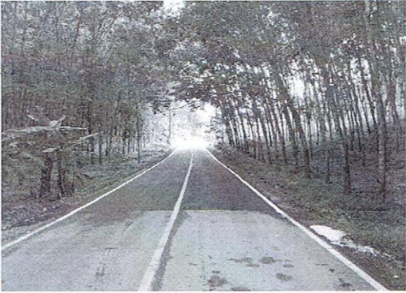
๗. โครงการก่อสร้างถนนลาดยางสายกอบแกบ-เขาน้อย หมู่ที่ ๖
